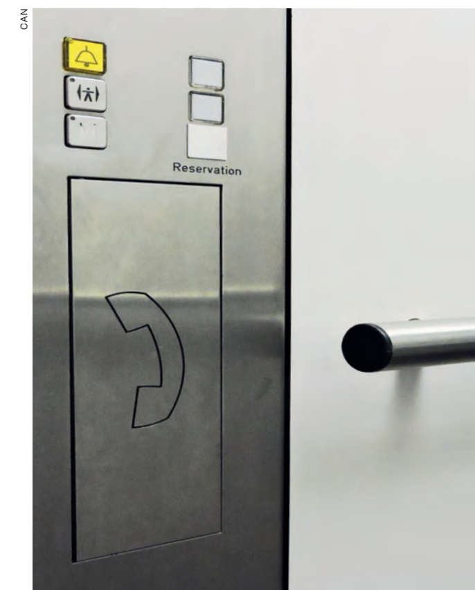
Notruf im Lift: Zukunftstaugliche Lösung ausstehend
